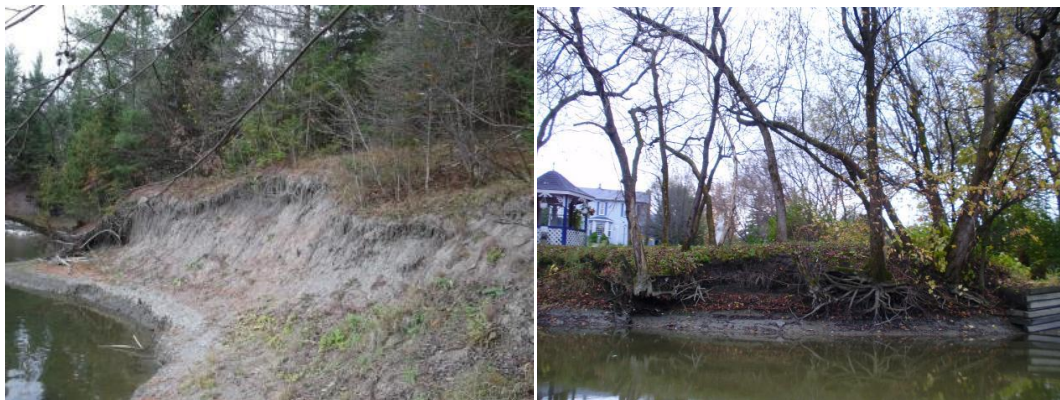
Figure 72. Érosion de la rivière Blanche Ouest dans le secteur de Gatineau
