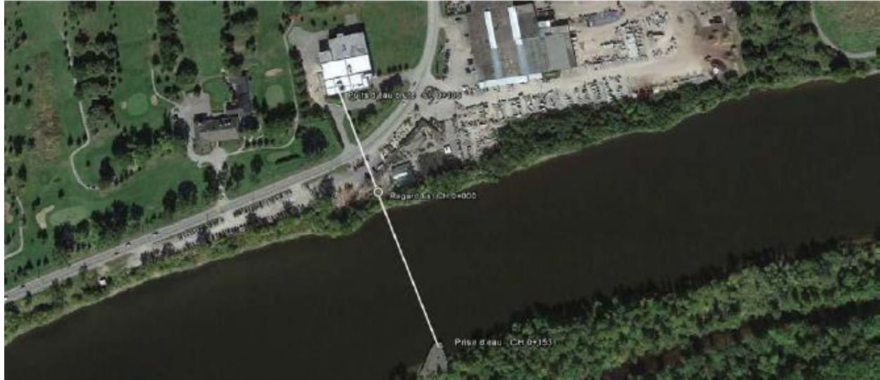
Figure 1-6: Position approximative de la prise d'eau de Gatineau (WSP, 2015)
