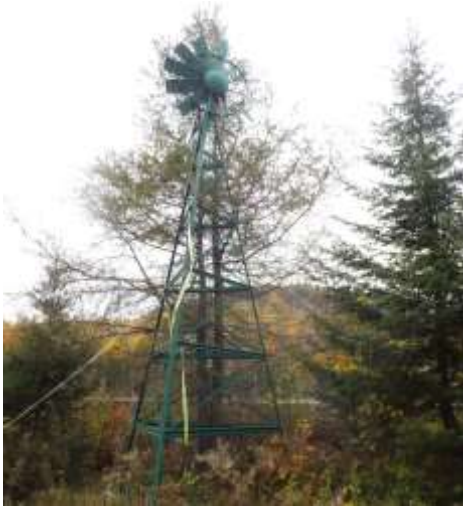
Photo 11 : Une des deux éoliennes
