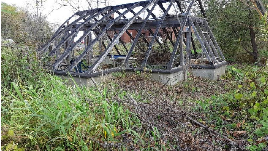
Photo 17 : Construction dans le littoral
