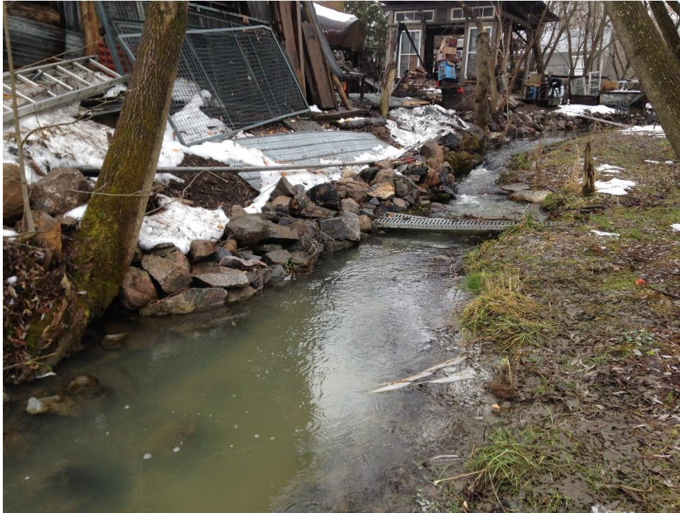
Photo 3 : Enrochement dans la rive et le littoral du ruisseau.
