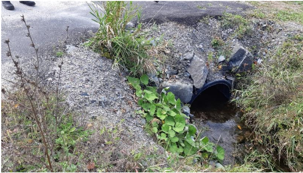
Photo 15 : Érosion par l'eau de ruissellement et absence de végétation stabilisante
